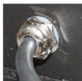
wyprowadzony przewód zasilający 3x1mm 2
