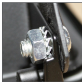
mocowanie uchwyty z oprawą (podkładki zębate)
