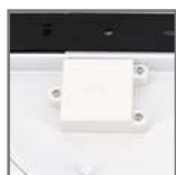
zamknięte złącze przyłączeniowe
